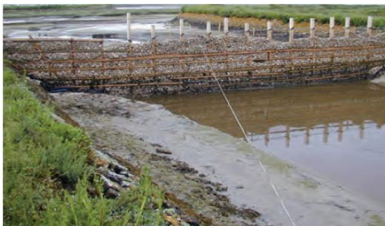
图7 岸上发生泄漏的围堵示意图
